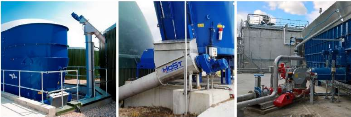
Rys. 4b. Integracja zasobnika substratów sypkich z komorą fermentacyjną.
